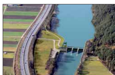
LAUFKRAFTWERK AM INN
